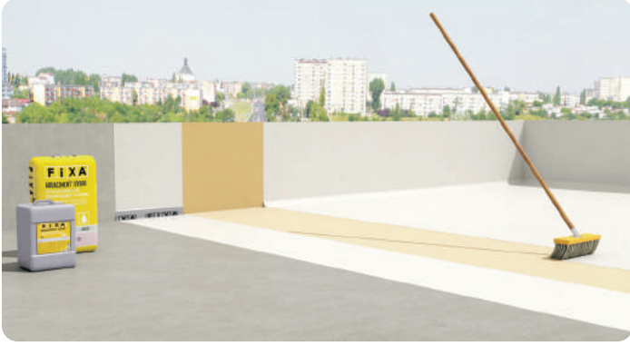
Teras çatıların yalıtımında
