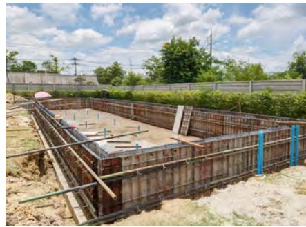
Şekil 3: Havuz kazısı ve kalıp uygulaması
