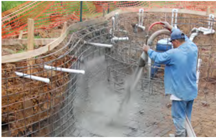
Şekil 2b: Kalıpsız inşaat tekniği ile imal edilen betonarme havuzlar
