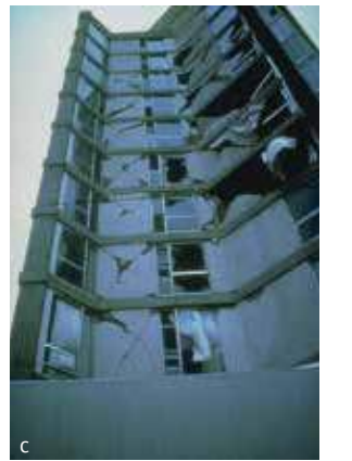
Resim 2. Deprem sonrası oluşan yapısal hasarlar. (a) Perde duvar-temel alt bölge burkulma. (b) Perde duvar-döşeme üst bölge burkulma. (c) Perde duvar kesme çatlakları.
