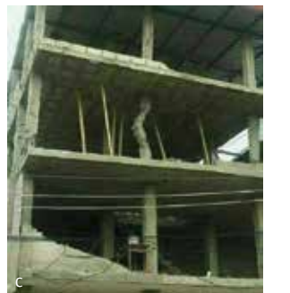
Resim 3. Deprem sonrası oluşan yapısal hasarlar. (a) Kolon burkulma ve mesnet koşullarına ait hasar. (b) Kolon burkulma hasarı (Eğilme ve kesme kuvvetleri aşımı). (c) Kolon burkulma hasarı.
