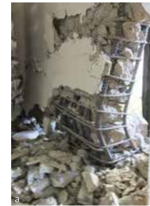
Resim 2. Deprem sonrası oluşan yapısal hasarlar. (a) Perde duvar-temel alt bölge burkulma. (b) Perde duvar-döşeme üst bölge burkulma. (c) Perde duvar kesme çatlakları.
