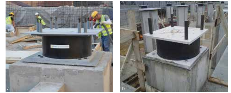
Resim 7. Temel izolatörleri. (a) Temel üstü bağlantı öncesi. (b) Kolon üstü bağlantı öncesi.
