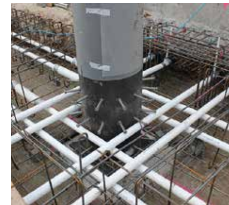
Resim 11. Farklı türden bağlantılar; kompozit kolon ile temel bağ kirişi bağlantı detayı.
