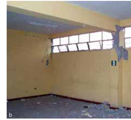
Resim 1. Deprem sonrası oluşan yapısal hasarlar. (a) Köprü ayaklarında meydana gelen kesme kuvveti ve eksenel yük kapasite aşımı. (b) Kısa kolon etkisi. (c) Kolon-temel birleşim bölgesi.
