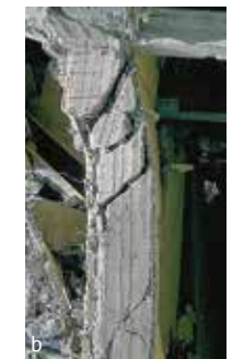
Resim 3. Deprem sonrası oluşan yapısal hasarlar. (a) Kolon burkulma ve mesnet koşullarına ait hasar. (b) Kolon burkulma hasarı (Eğilme ve kesme kuvvetleri aşımı). (c) Kolon burkulma hasarı.
