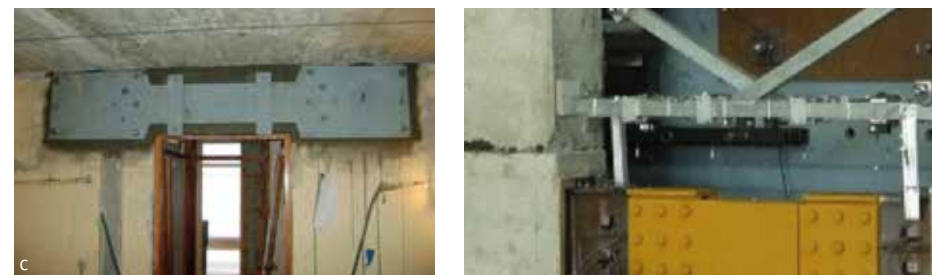
Resim 6. Perde duvarlar arası kısa kirişler. (a) Çelik profil kompozit tür bağ kirişi. (b) Çelik levhalardan oluşan güçlendirilmiş betonarme bağ kirişi. (c) Yapma profillerden oluşan farklı enkesitli çelik bağ kirişi. (d) Çelik profillerden oluşan farklı bağlantı türlü bağ kirişi.
