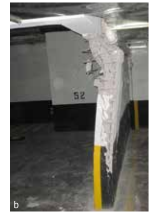
Resim 2. Deprem sonrası oluşan yapısal hasarlar. (a) Perde duvar-temel alt bölge burkulma. (b) Perde duvar-döşeme üst bölge burkulma. (c) Perde duvar kesme çatlakları.
