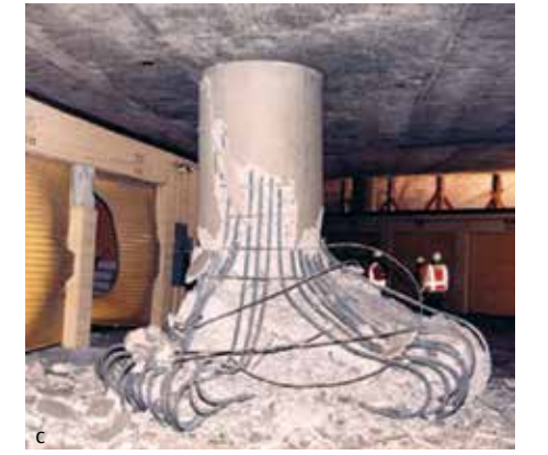
Resim 1. Deprem sonrası oluşan yapısal hasarlar. (a) Köprü ayaklarında meydana gelen kesme kuvveti ve eksenel yük kapasite aşımı. (b) Kısa kolon etkisi. (c) Kolon-temel birleşim bölgesi.
