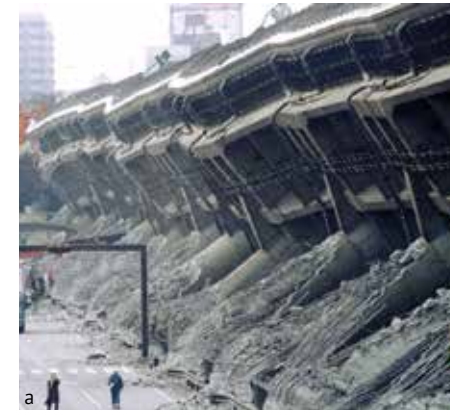
Resim 1. Deprem sonrası oluşan yapısal hasarlar. (a) Köprü ayaklarında meydana gelen kesme kuvveti ve eksenel yük kapasite aşımı. (b) Kısa kolon etkisi. (c) Kolon-temel birleşim bölgesi.
