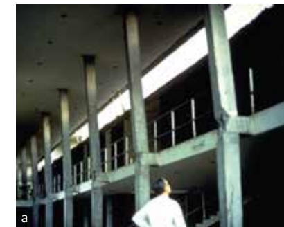
Resim 3. Deprem sonrası oluşan yapısal hasarlar. (a) Kolon burkulma ve mesnet koşullarına ait hasar. (b) Kolon burkulma hasarı (Eğilme ve kesme kuvvetleri aşımı). (c) Kolon burkulma hasarı.
