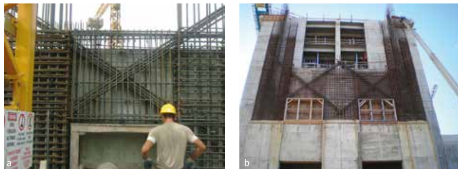
Resim 5. Perde duvarlar arası kısa kirişler (bağ kirişleri). (a) Asansör kapısı üstü boşluk kirişi. (b) Dış cephe pencere boşlukları üstü boşluk kirişi.
