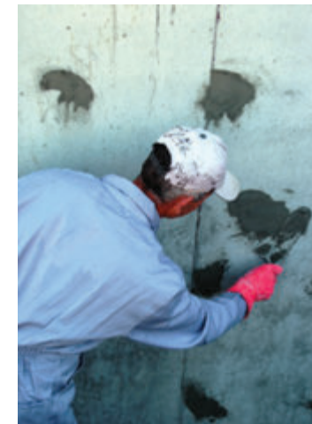
Temel - perde yalıtımlarında yüzey hazırlığı
